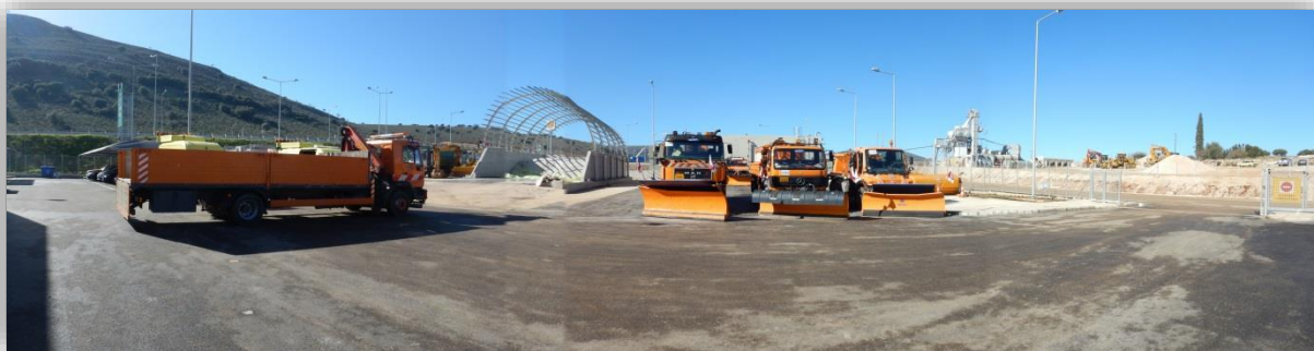
Σταθμός αποχιονισμού ΚΕΣ Αμφιλοχίας
